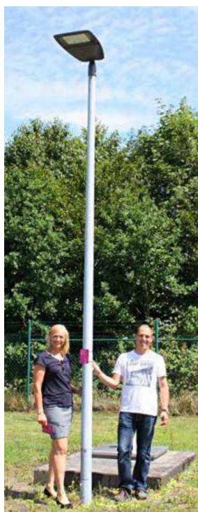
Monika Schürmann, innogy-Kommunalbetreuerin, freut sich, dass mit den neuen LED-Lampen in der Kläranlage nicht nur die Energiewende vorangetrieben, sondern auch die Arbeitssicherheit verbessert wird.
