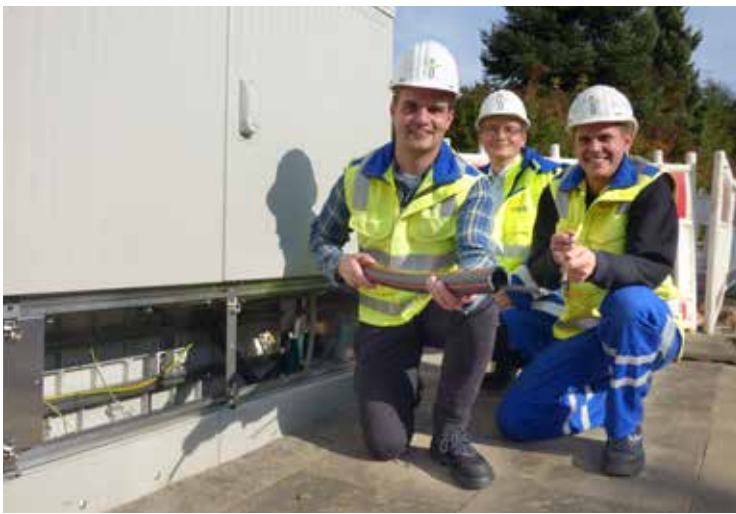
Steffen Wilken (links) und Johannes Geers (Mitte) mit dem für Hüllhorst zuständigen Netzmeister Thomas Ellermann (rechts) an einem der neuen Knotenpunkte für schnelles Internet.
