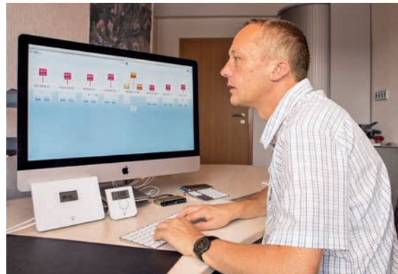
Zukunftsorientiert: In Pfeffelbach nutzt der Bauhof SmartHome von der OIE. Initiiert hat die Installation Frank Aulenbacher
