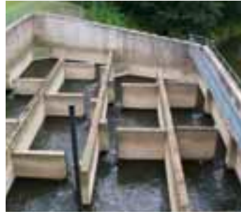
Investition in Naturschutz und Erzeugungsleistung: Über die Fischtreppe am Wasserkraftwerk Nassau (links) wandern Lachse sicher flussaufwärts zu ihren Laichplätzen. In der Anlage Kalkofen (rechts) hat die Süwag 2015 unter anderem die Turbinen modernisiert.
