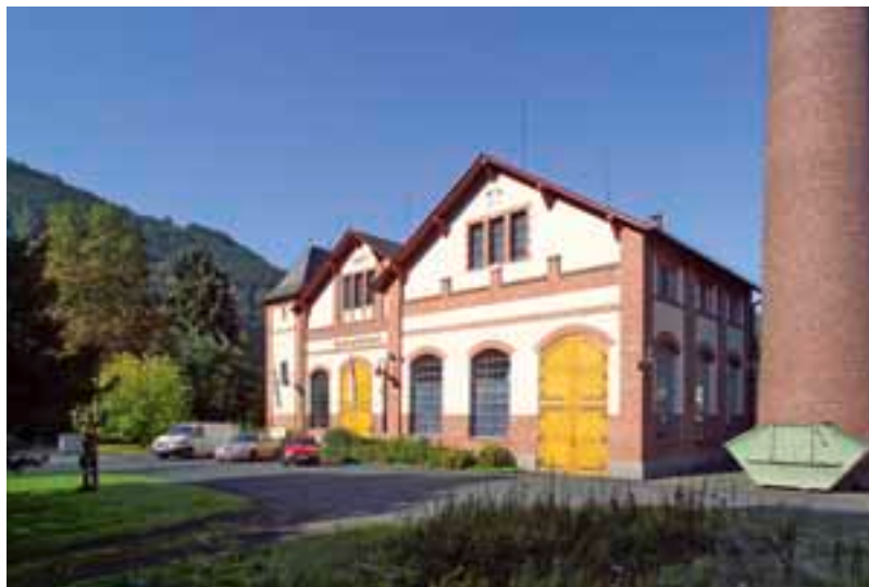
Die drei Stromgeneratoren im Maschinenhaus des Wasserkraftwerks Altwied (links) und die historische Anlage an der Lahn in Friedrichsseggen (rechts)
