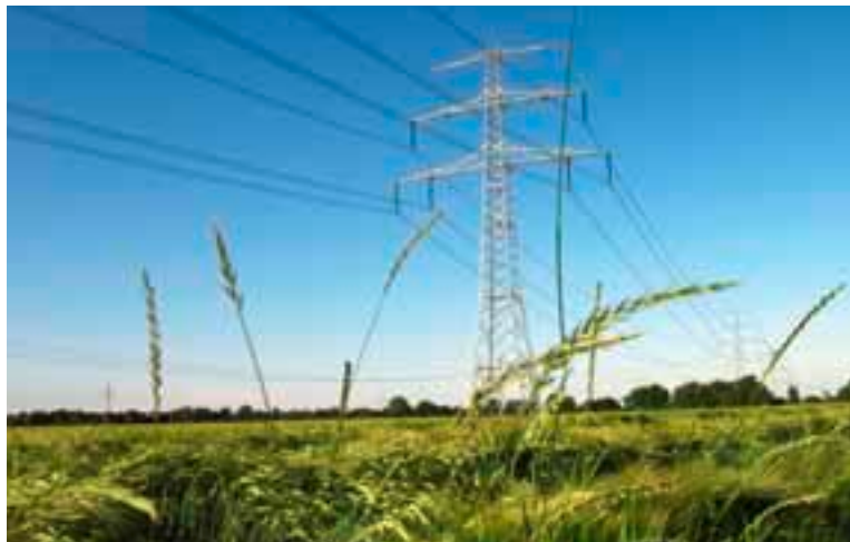
Sicher versorgt: Die Syna GmbH baut in Bad Soden eine moderne Umspannanlage und stärkt damit das regionale Stromnetz für künftige Anforderungen.
